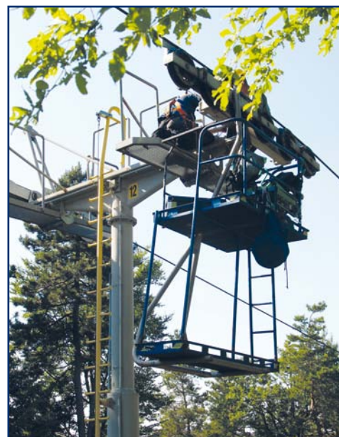
Údržba na trase lanovky
