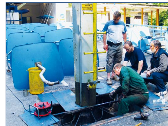
Defektoskopia oceľových konštrukcií – podpera č. 1
