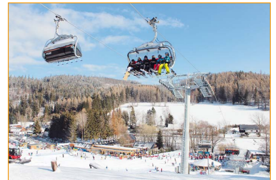
Dolní část trasy lanovky – podpora č. 3
