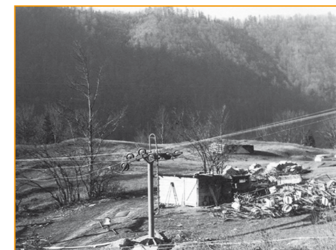
Tlačná podpera č. 8 za budúcou medzistanicou Salašky po roztiahnutí a osadení dopravného lana, v pozadí pripravené sedačky
