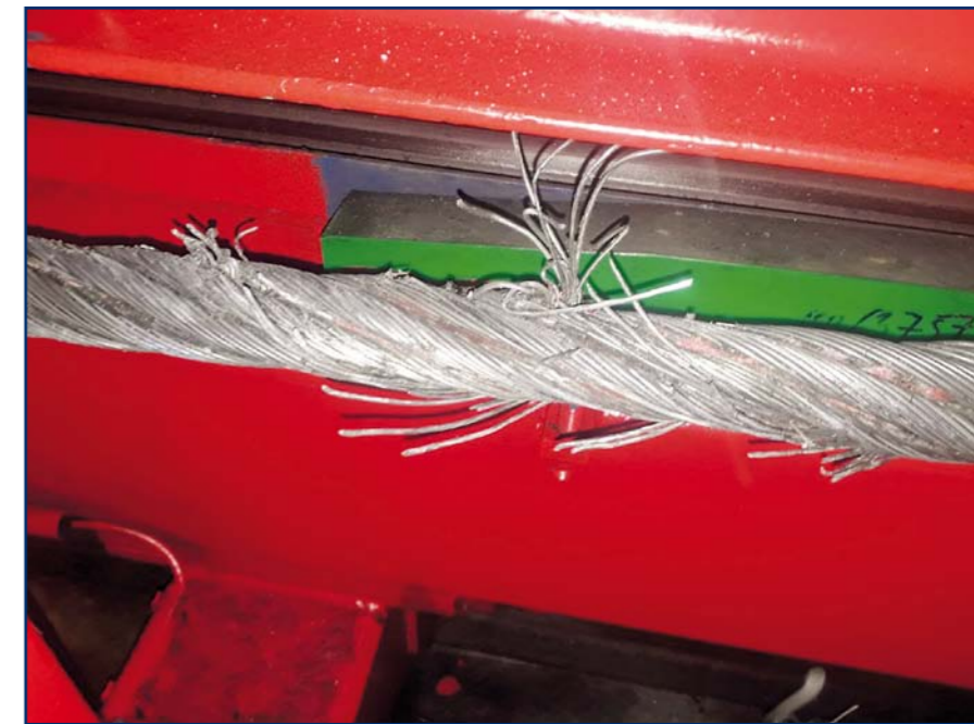
V důsledku zaklínění kabiny, resp. spínacího aparátu ve stanici utrpělo dopravní lano řadu zlomů drátů. (Foto: Bergbahn AG Kitzbühel/Florian Wörgetter)
