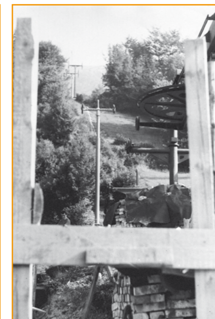
Pohľad z rozostavanej dolnej stanice na trasu lanovky po montáži strojového zariadenia
