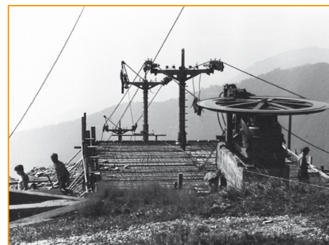
Po montáži strojového zariadenia pokračuje výstavba budovy hornej stanice
