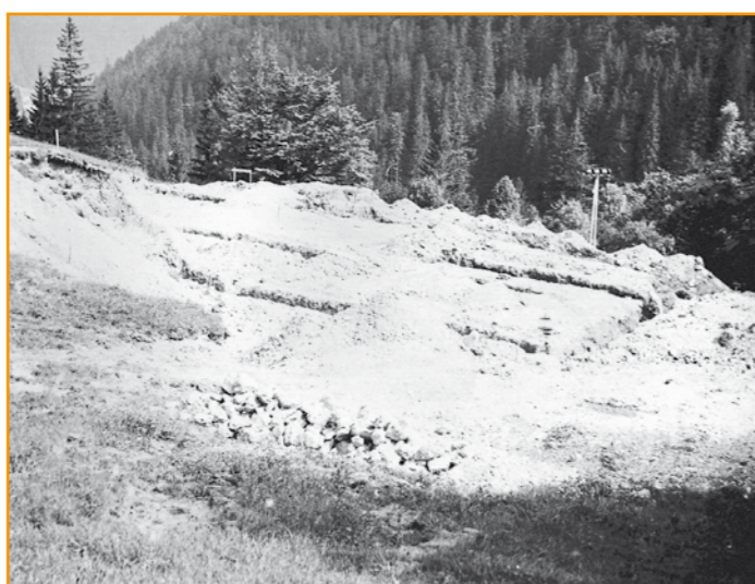
Vykopané základové ryhy pre budovu dolnej stanice v Tureckej
