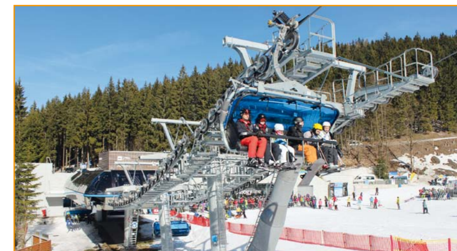
Dolní stanice se skupinou výjezdových podpěr
