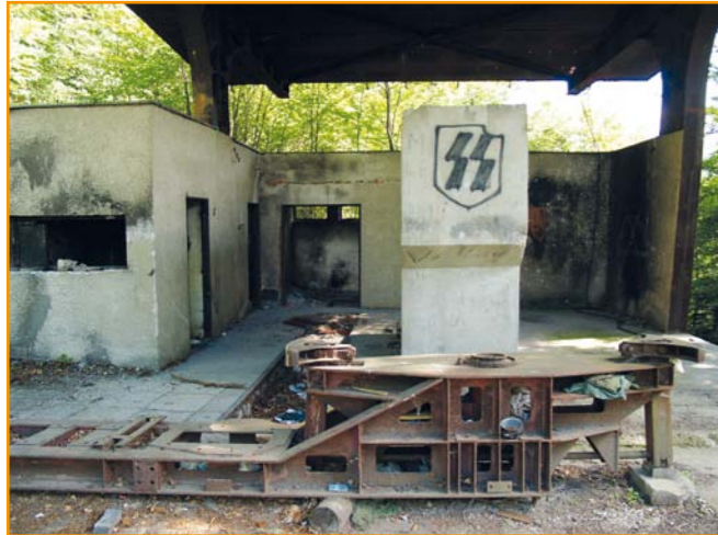
Horná stanica lanovky na Srnkovej a hlavný nosník pohonu v roku 2007
