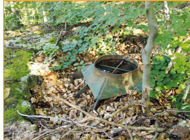
Fotografia dokazuje, že aspoň niektoré z podpier lanovky na Srnkovej skutočne stáli – stojka jednej z podpier so zvyškom odrezaného rúrového drieku (stav v roku 2007)
