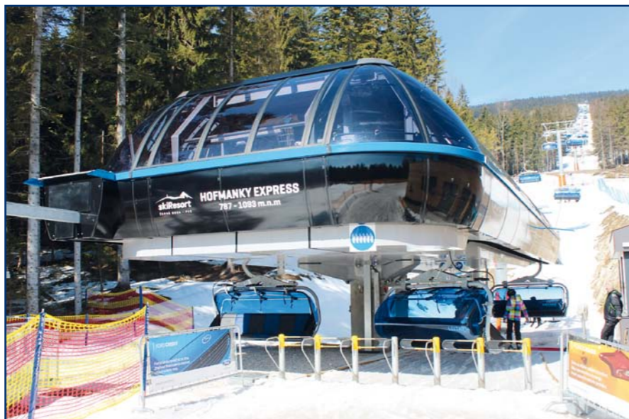
Dolní poháněcí stanice lanovky Hofmanky Express
