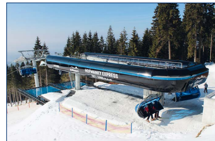
Horní vratná stanice lanovky Hofmanky Express
