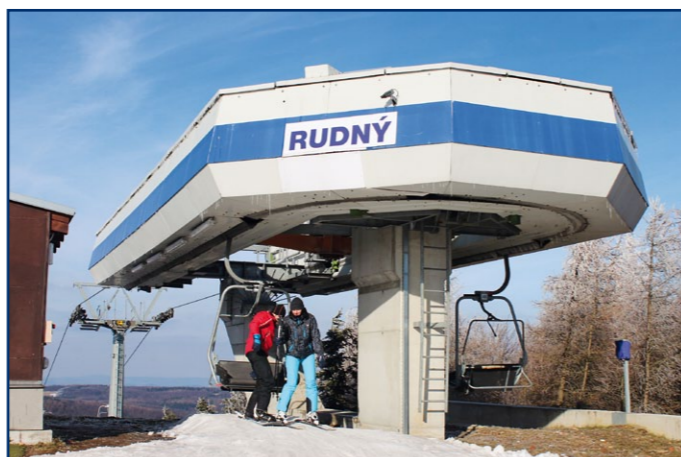
Horní vratná stanice s nízkým opláštěním
