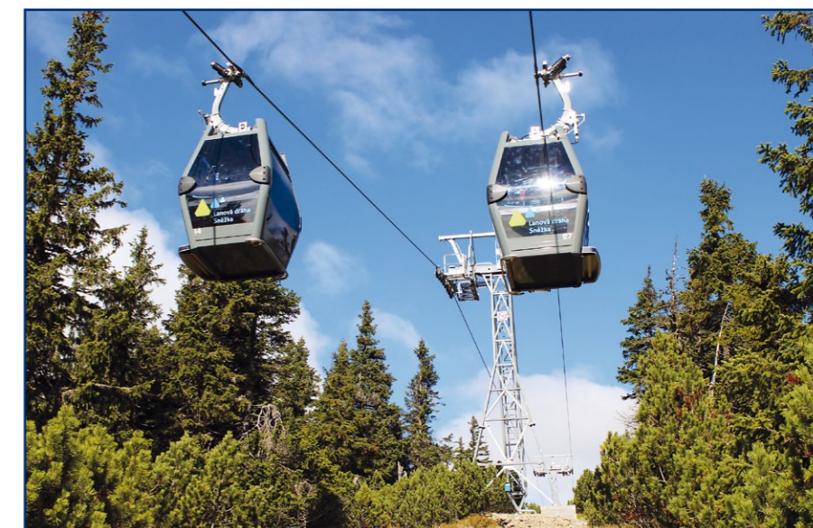
Podpěra č. 2 druhého úseku
