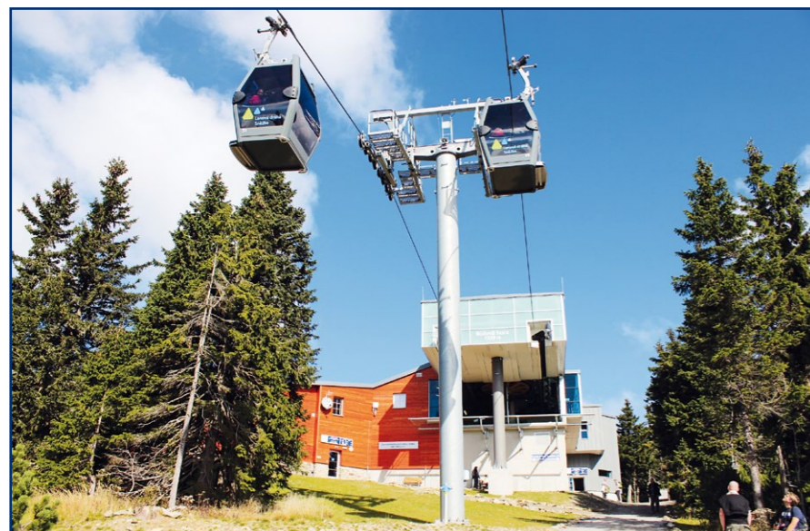
Poslední podpěra č. 17 prvního úseku a mezistanice na Růžové hoře
