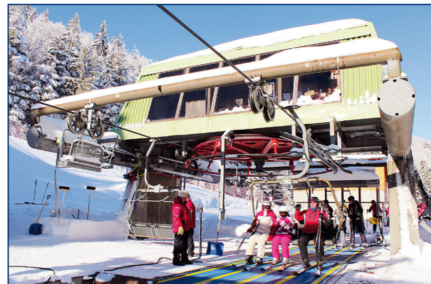
Dolní poháněcí stanice čtyřsedačkové lanovky na Červenohorském sedle
