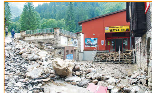
Vstup do stanice lanovky, ktorým vytekla voda
