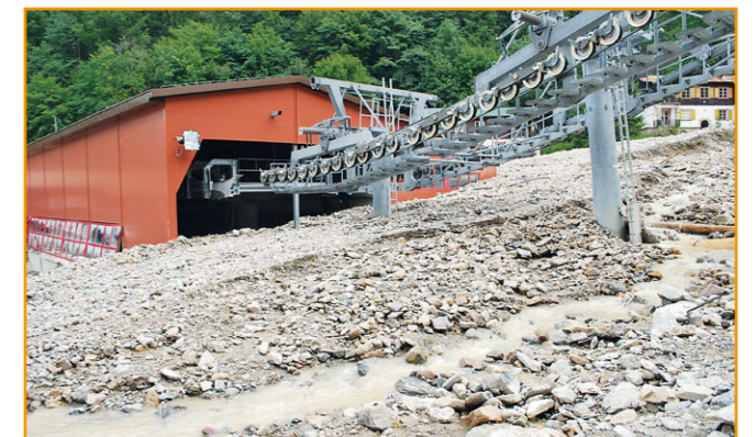
Výjazd vozňov zo stanice
