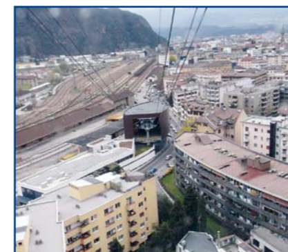
Pohľad z lanovky na osadenie údolnej stanice
