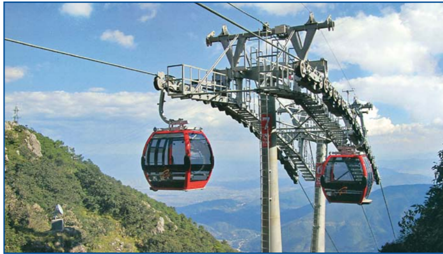
Kto si chce ušetriť vyše tisíc kamenných schodov, využije pre hornú – obzvlášť namáhavú – tretinu cesty novú kabínovú lanovku Doppelmayr
