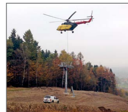
Montáž trate lanovej dráhy
