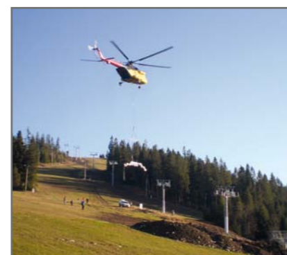
Montáž traťových podpier
