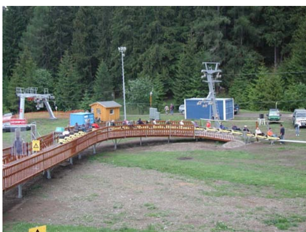
Celkový pohled na bobovku v areálu Žiarce, Pavčina Lehota. V pozadí lyžařský vlek jako dopravník bobů do horní stanice.
