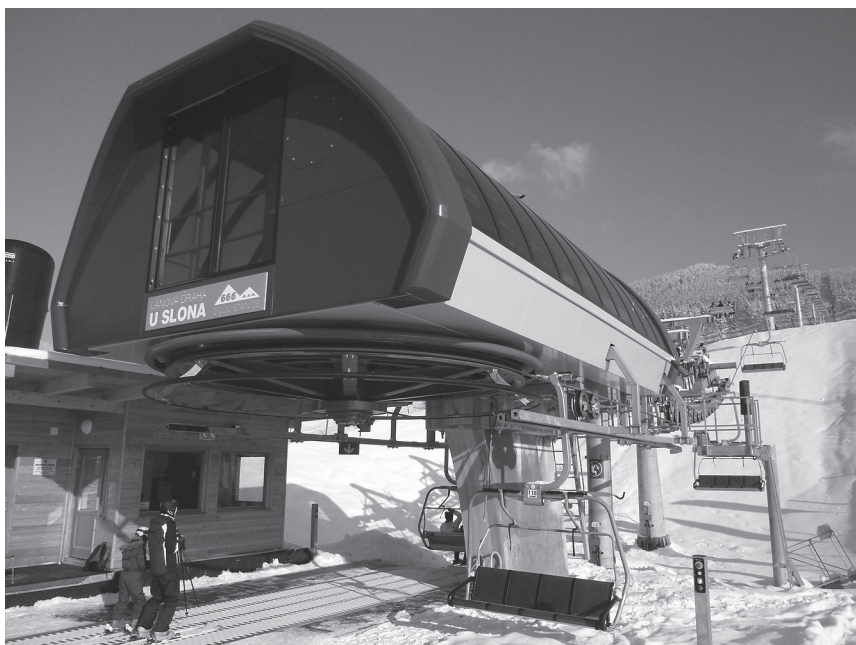
Údolná stanica neodpojiteľnej 4-miestnej sedačkovej lanovky U Slona v Dolnej Morave je ako prvá v ČR realizovaná vo verzii s vysokým prestrešením v dizajne UNI-G
