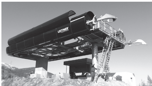
Prvá lanovka firmy Leitner na Slovensku - montáž vratnej stanice
