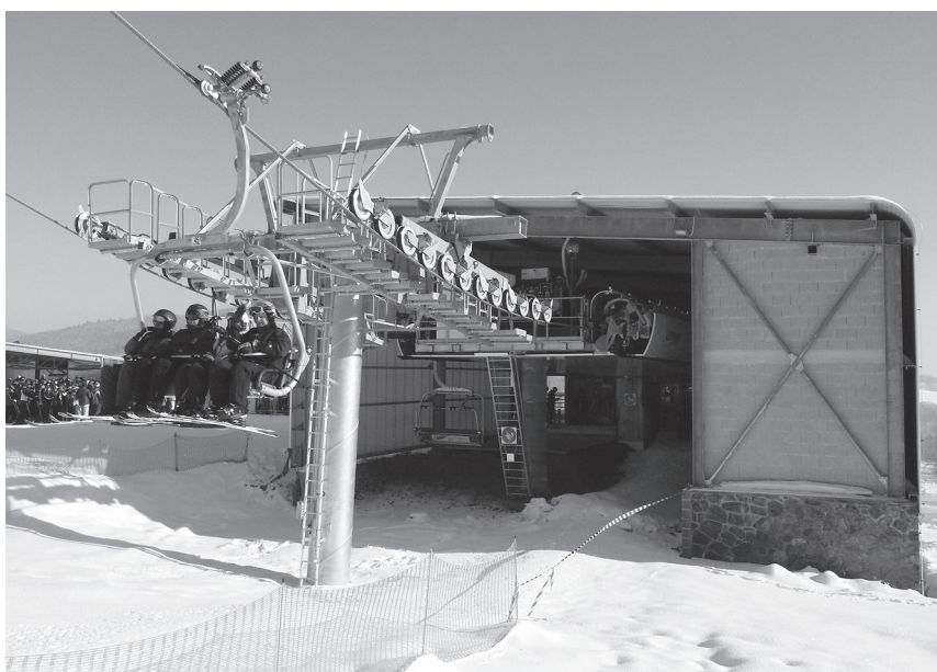
Údolná stanica 4-miestnej sedačkovej lanovky s vyhrievanými sedadlami Červená Voda – Buková hora
