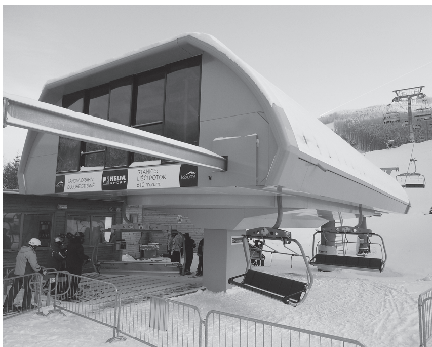
Údolná stanica 6-miestnej sedačkovej lanovky v Koutech nad Desnou
