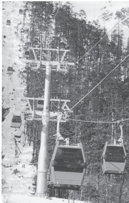
Pohľad na líniu lanovky
