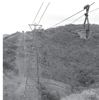
Vozíky nákladnej lanovky cementárne v Apiai
