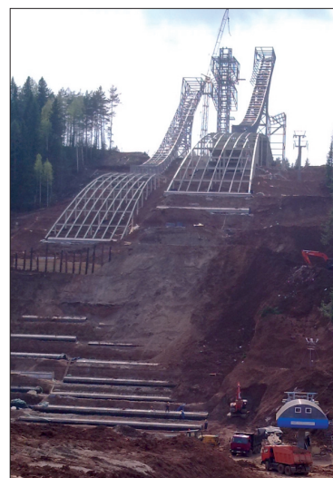
Časť strediska Snežinka vo výstavbe
