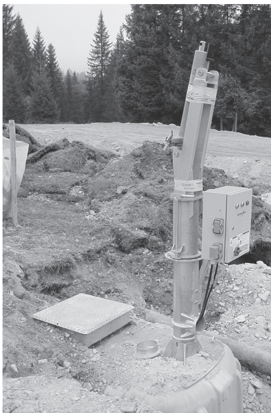
Celkove sa dodá do Laaxu 81 PE-šacht. Šachty sú tak koncipované, že poskytujú potrebný podklad a požadovanú stabilitu pre montáž snežných kanónov
