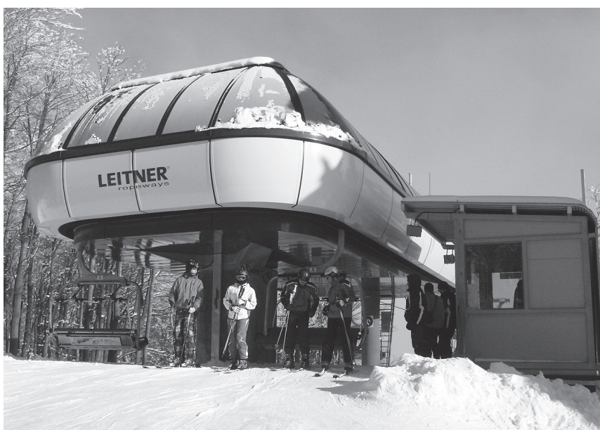
Vrcholová stanica prvej úplne novej lanovky Leitner v ČR na Bukovej hore
