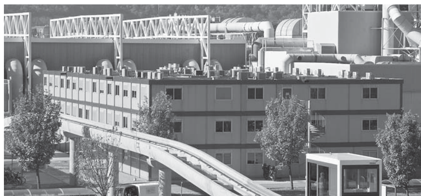
Jedinečný prepravný systém v budove výskumného ústavu CEA Grenoble
