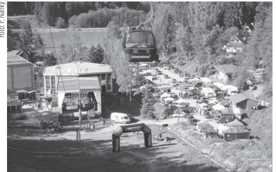
Údolná stanica kabínkovej lanovky v stredisku Ružomberok - Malinô Brdo
