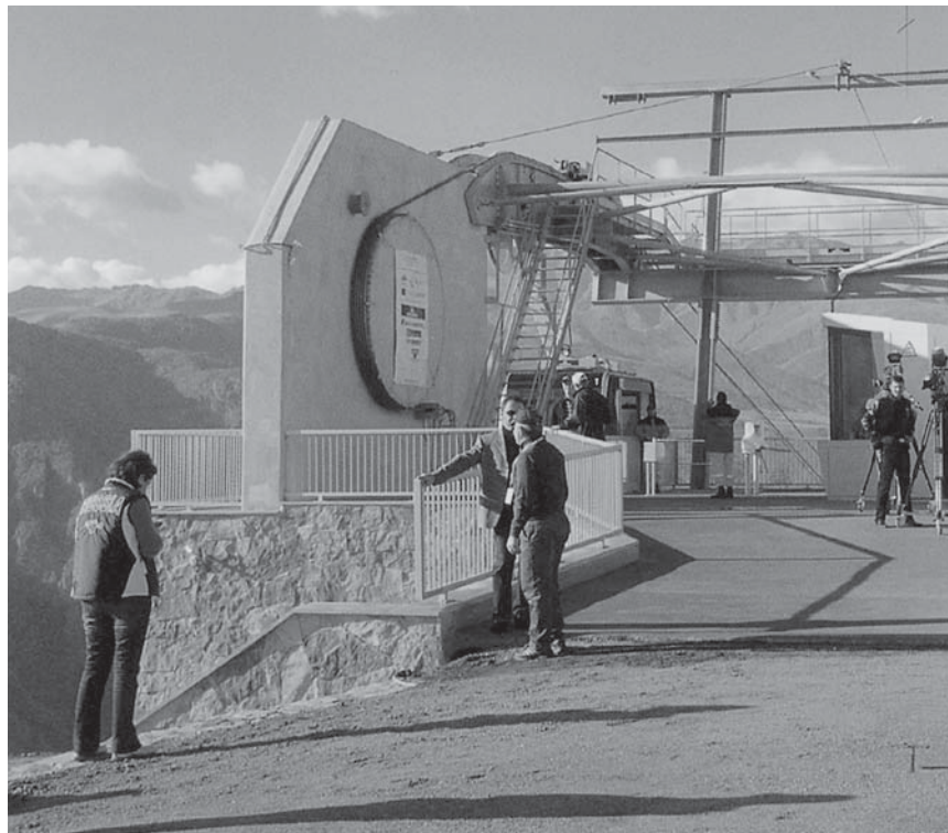
Lanovka je veľmi plochá. Stanica Halidzor je otvorenej konštrukcie, vchod je zastrešený sklom
