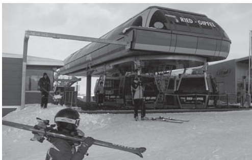
Vrcholová stanica 10-miestnej kabíny v Gipfelbahn
