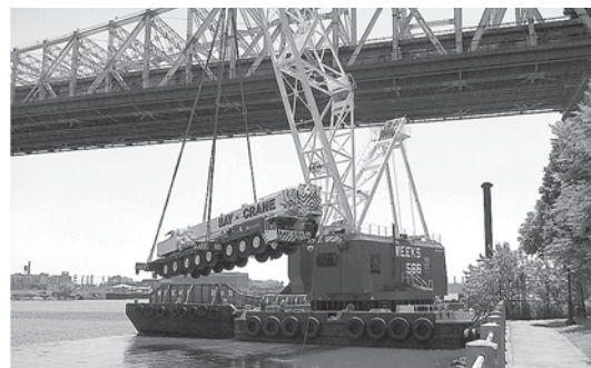
Vykládanie žeriava, ktorý asistoval pri montáži hláv traťových podpier
