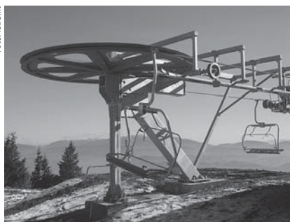
Vratná stanica sedačkovej lanovky SLF 4p na Kubínskej holi
