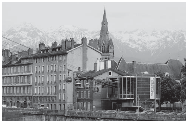
Údolná stanica je situovaná na brehu rieky Isère
