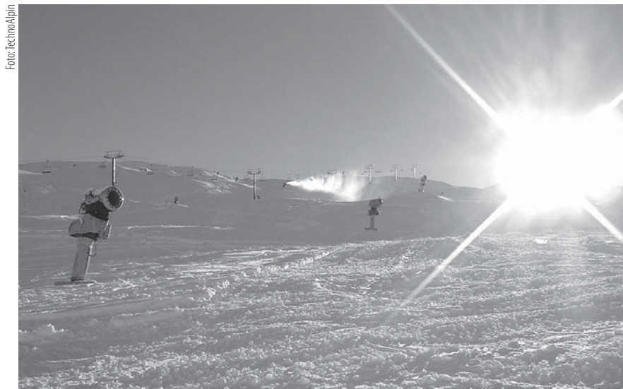
S celkovým počtom 202 snežných kanónov disponuje Coronet Peak najväčším zasnežovacím zariadením na južnej pologuli. Obzvlášť premyslené zásobovanie vodou, ktorého základom sú pôvodné zdroje, ovplyvnilo ocenenie Engineering Excellence Award
