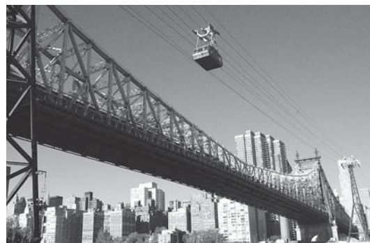
Prvá kabína lanovej dráhy inštalovaná na lanách nad East River
