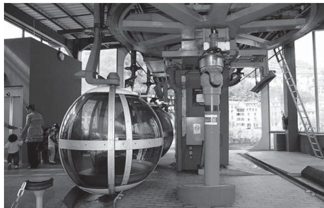
Pohľad do údolnej stanice lanovej dráhy
