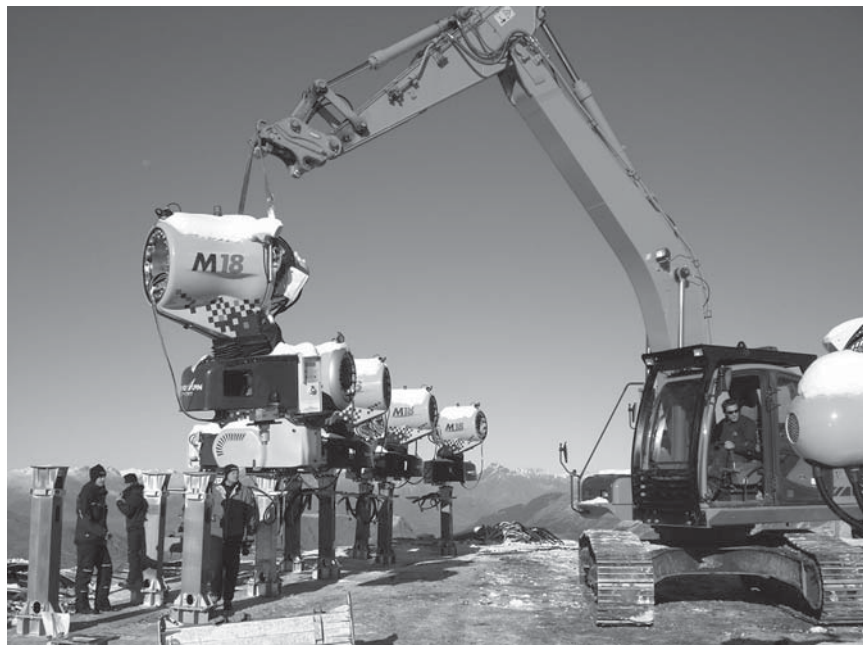
124 vrtuľových kanónov spolu so 78 snežnými tyčami zabezpečujú, že sa teraz môže v Coronet Peak vyrábať o 300 % viac snehu ako pred prestavbou
