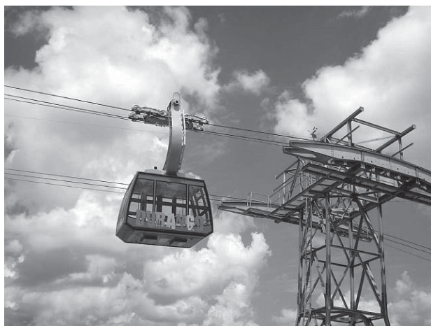
Moderný dizajn kabín lanovej dráhy láka k jazde nad historickou časťou Durangu
