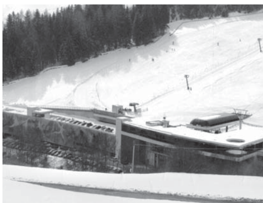
Údolná stanica s piatimi podlažiami
