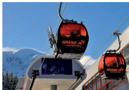
■ Údolná stanica novej lanovej dráhy GRAND JET
