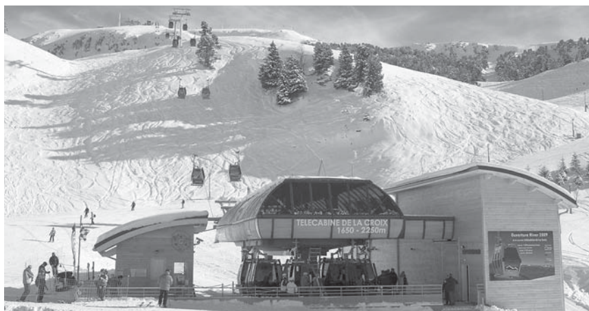
■ Údolná stanica kabínkovej lanovky Multix 8/10 La Croix
