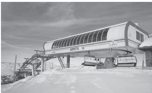
■ Pohľad na vrcholovú stanicu TSD-6 Les Arcs
