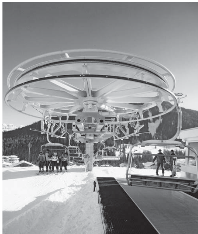
■ Pevná 4-miestna sedačková lanovka CF4 COLZ v stredisku La Villa (BZ), Taliansko. Technické údaje: dĺžka trate 206 m, prevýšenie 26 m, prepravná kapacita 1 720 os./h, výkon 48 kW
