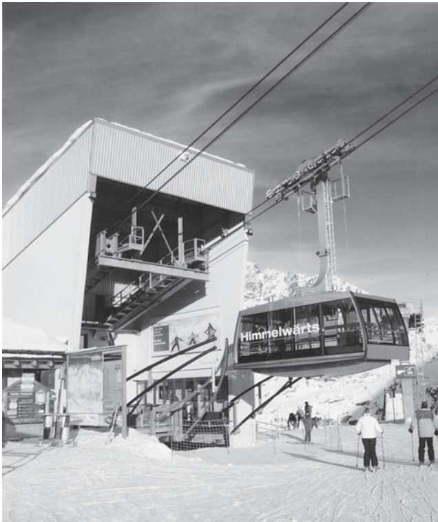
■ 3S systém lanovej dráhy AT101 Murtel v stredisku Corvatsch, Švajčiarsko. Technické údaje: dĺžka trate 1 672 m, prevýšenie 596 m, prepravná kapacita 1 200 os./h, výkon 730 kW
