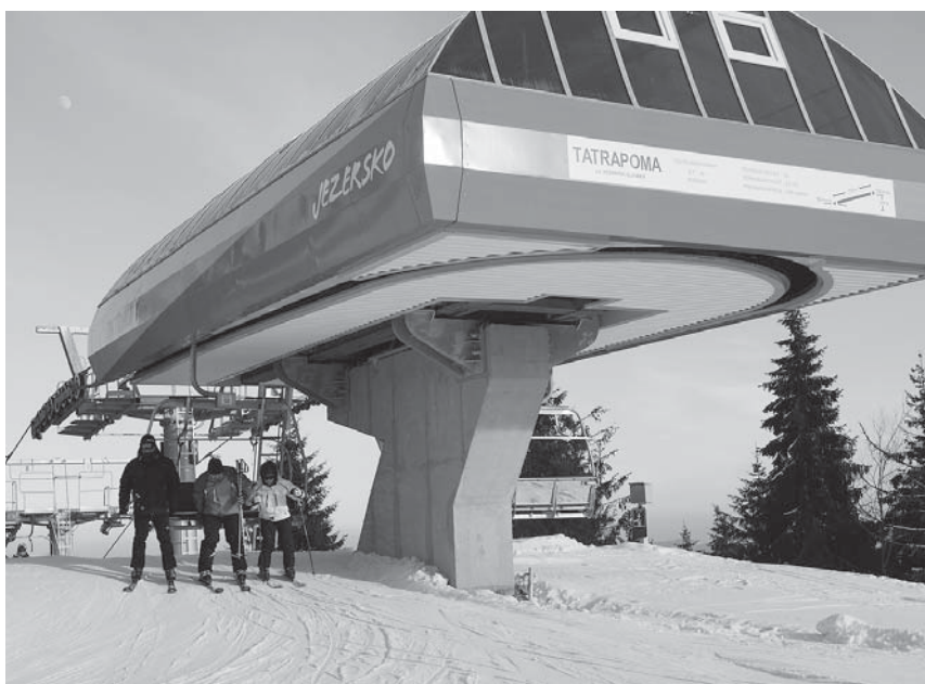
■ Vrcholová stanica lanovej dráhy v stredisku Bachledova dolina – Jezersko
