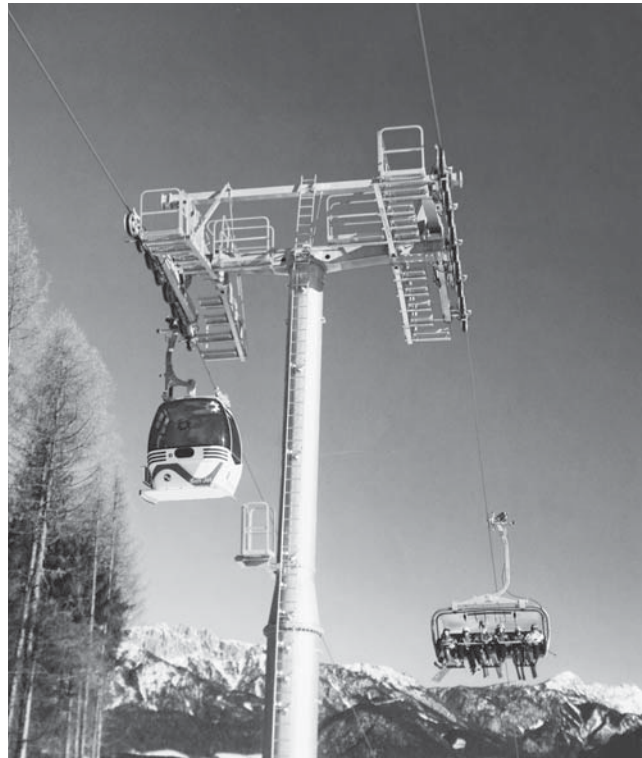
■ Kombinovaná lanová dráha TMX6-8 SUN – JET vybudovaná v stredisku Schladming, Rakúsko. Technické údaje: dĺžka trate 1 444 m, prevýšenie 408 m, prepravná kapacita 2 137 os./h, výkon 460 kW
