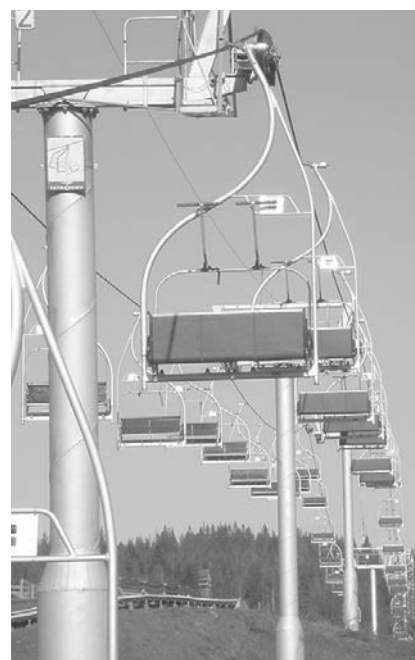
■ Zrekonštruované vozne TS 3 Bachledova dolina
