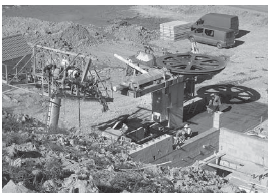
■ Z výstavby poháňacej stanice - práce v plnom nasadení
