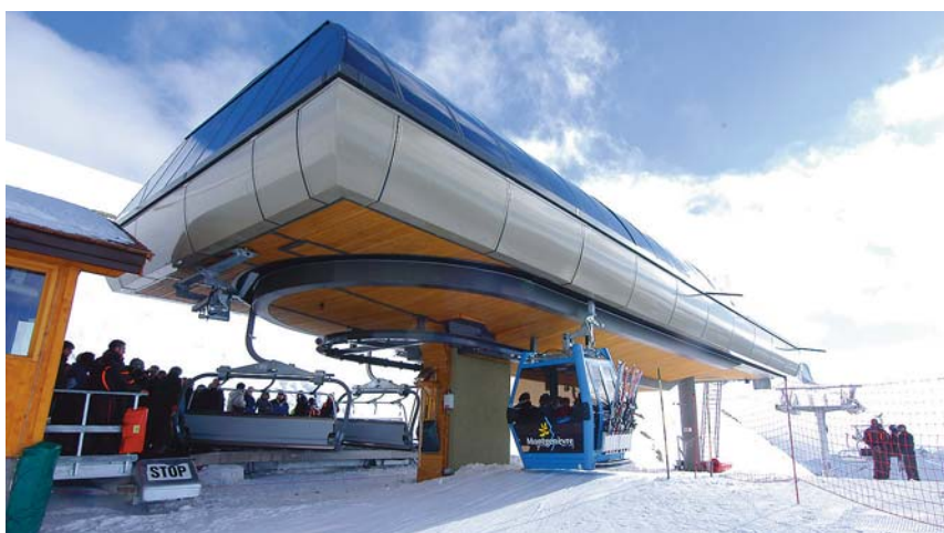
■ Vrcholová stanica lanovej dráhy Telemix Montgenèvre
