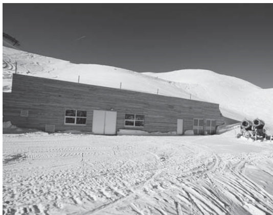
■ Vonkajší pohľad na čerpaciu stanicu Riezler Alpe
