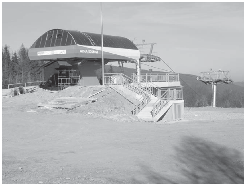
■ Poháňacia stanica TS4 Soszów pred dokončením montáže
