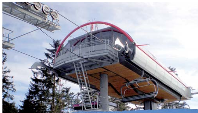
■ Stanica sedačkovej lanovky Tornik
