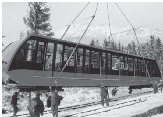
■ Osádzanie vozňa pozemnej lanovky na koľaje
