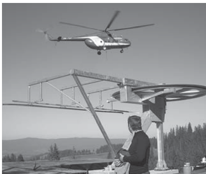
■ Vrtuľník pomáhal pri montáži vratnej stanice LD Czarna Gora
