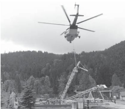
■ Výstavba sedačkovej lanovky na Kasprov vrch zo Zakopaného
