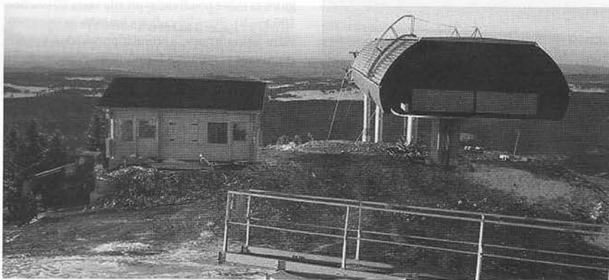
■ Vrcholová stanica lanovej dráhy MULTIX 6 v stredisku Les Loges-Lelex
