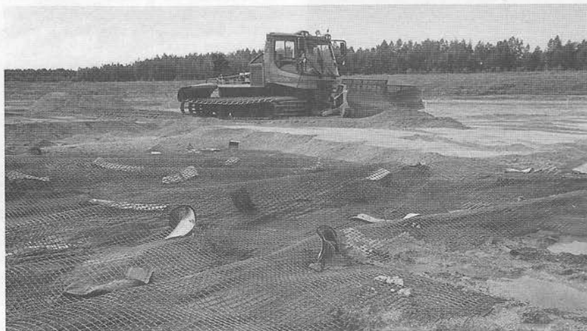
■ Kalové nádrže sú stabilizované geotechnickými materiálmi a prekryté viacerými vrstvami minerálnej pôdy
