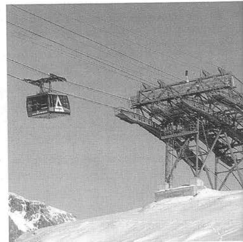
■ Nový Funifor má 2 kabíny pre 80 cestujúcich a 2 podpery z hrazdenej konštrukcie so 42 m, resp. 18 m výškou. Systém je veľmi stabilný voči vetru a nevyžaduje si žiadne nájazdové zariadenia
