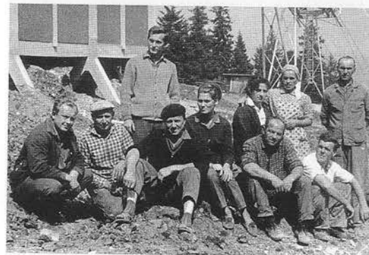
■ Pracovníci počas výstavby v r. 1967 pri vrcholovej stanici
