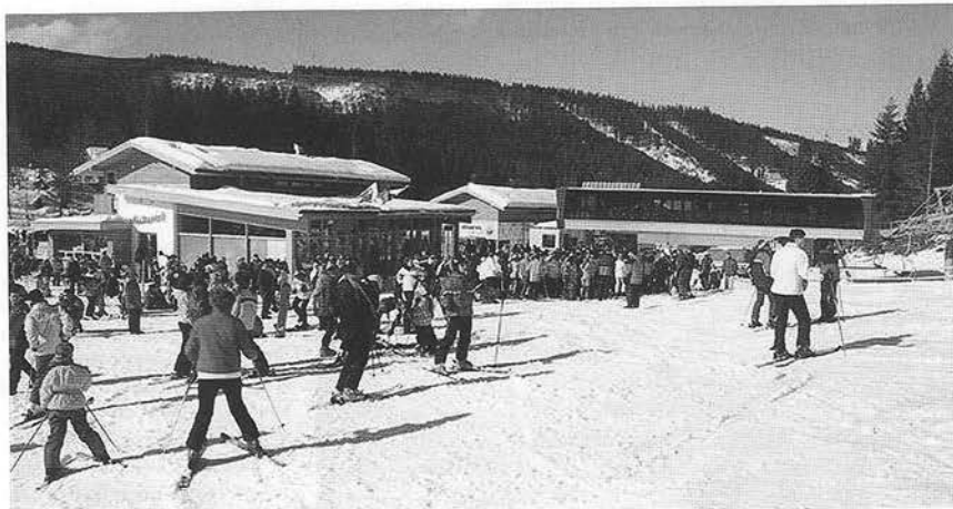
■ Súbor budov pre služby a údolná stanica lanovky v stredisku Oravice
