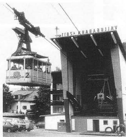
■ Údolná stanica existujúcej lanovky Galzig
