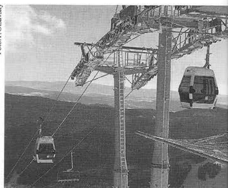
■ Kabíny a sedačky novej lanovky na trati
