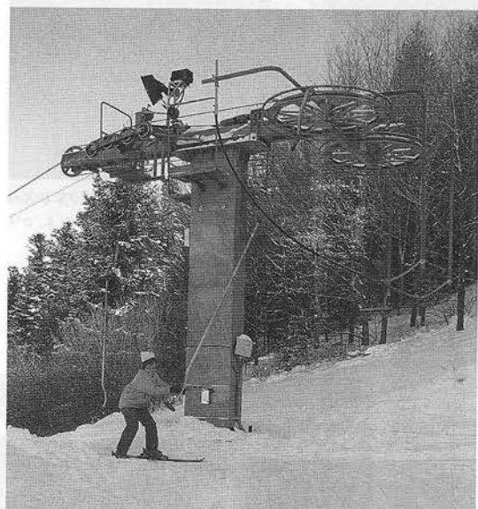
■ Niedzica – pevná vratná stanica lyžiarskeho vlekú s pevným uchytením teleskopického závesu umožňujúca výstup pod vratným kotúčom. Vývoj Tatrapoma, a. s., rok výroby 1998
