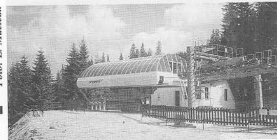
■ Poháňacia stanica s pohonom a napínaním lanovej dráhy TSD 4
