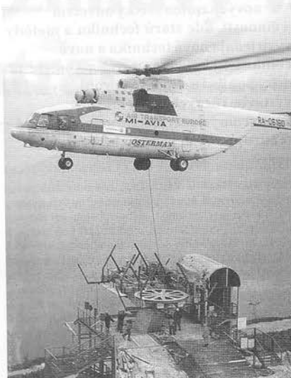
■ Montáž VS pomocou vrtuľníka s nosnosťou 20 t
