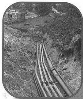
Jednoduchá pokládka liatinových potrubí
