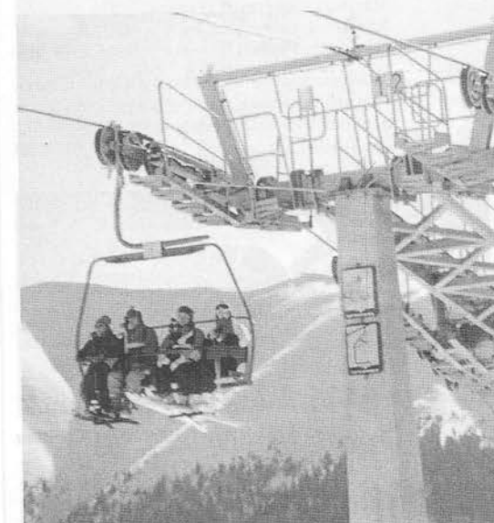
■ Lanovú dráhu SRDIEČKO - KOSODREVINA TSD 4 uviedli do prevádzky v roku 1994
