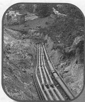
Jednoduchá pokládka hliníkových potrubí
