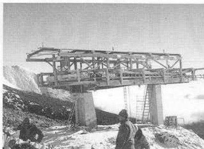
■ Výstavba a montáž vrcholovej stanice LD Solisko Express
