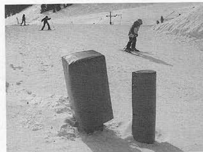
■ Príklad dôkladnej ochrany zasnežovacích zariadení
